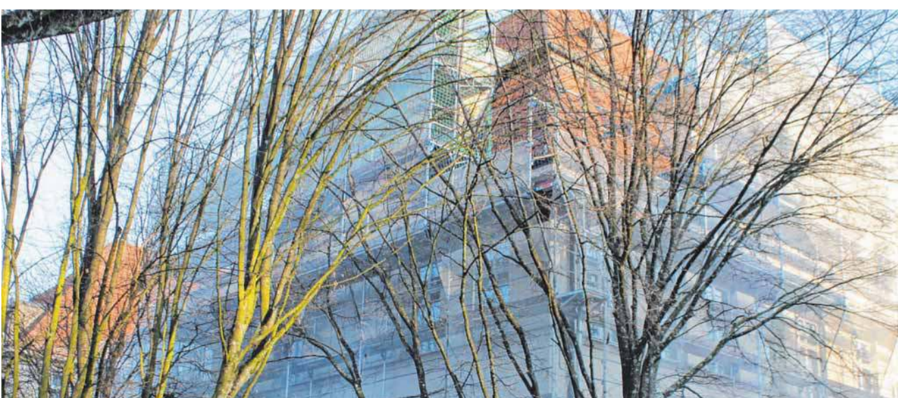
Die Umbauzeit für AEG und Spohngymnasium ist geplant bis August 2019. Dann soll der 4. Bauabschnitt umgesetzt sein.
