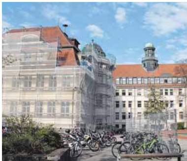
Die Sanierungsarbeiten am Spohn- und Albert-Einstein-Gymnasium sind in vollem Gange. FOTO: JOHLER
